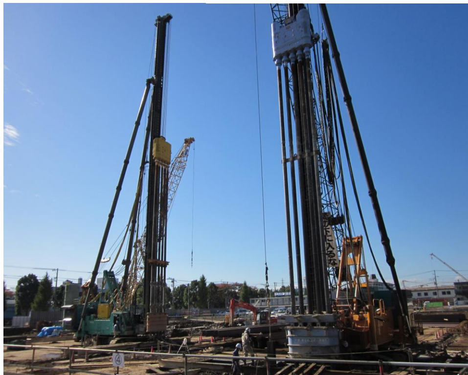
続壁山留工事施工状況】
