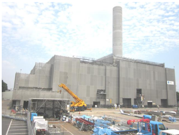
【工事現場全景】
