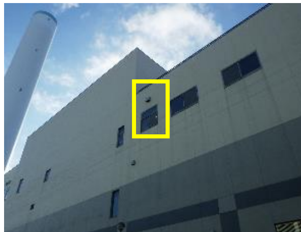
渡り廊下接続箇所（外観）
