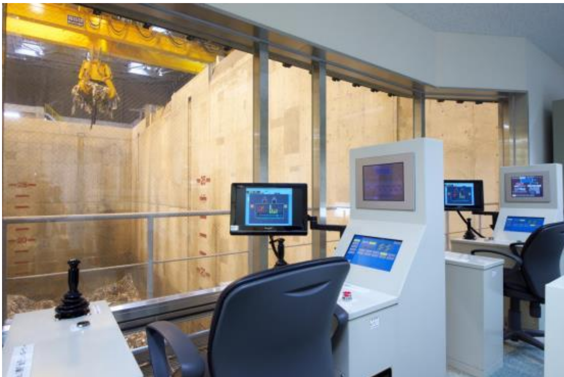
クリーンプラザふじみごみピット
