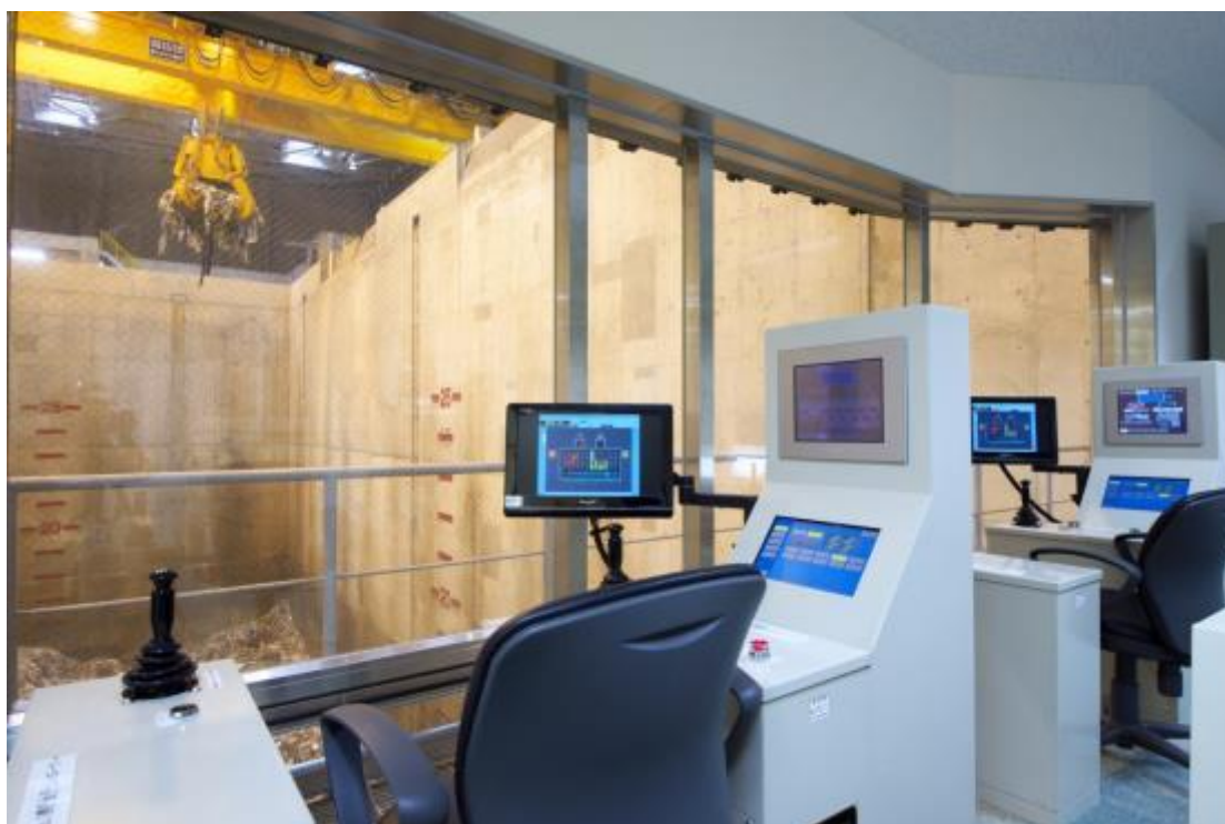
クリーンプラザふじみごみピット
