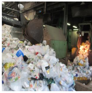
供給コンベヤ プラットホームから各ラインにごみを送ります。
