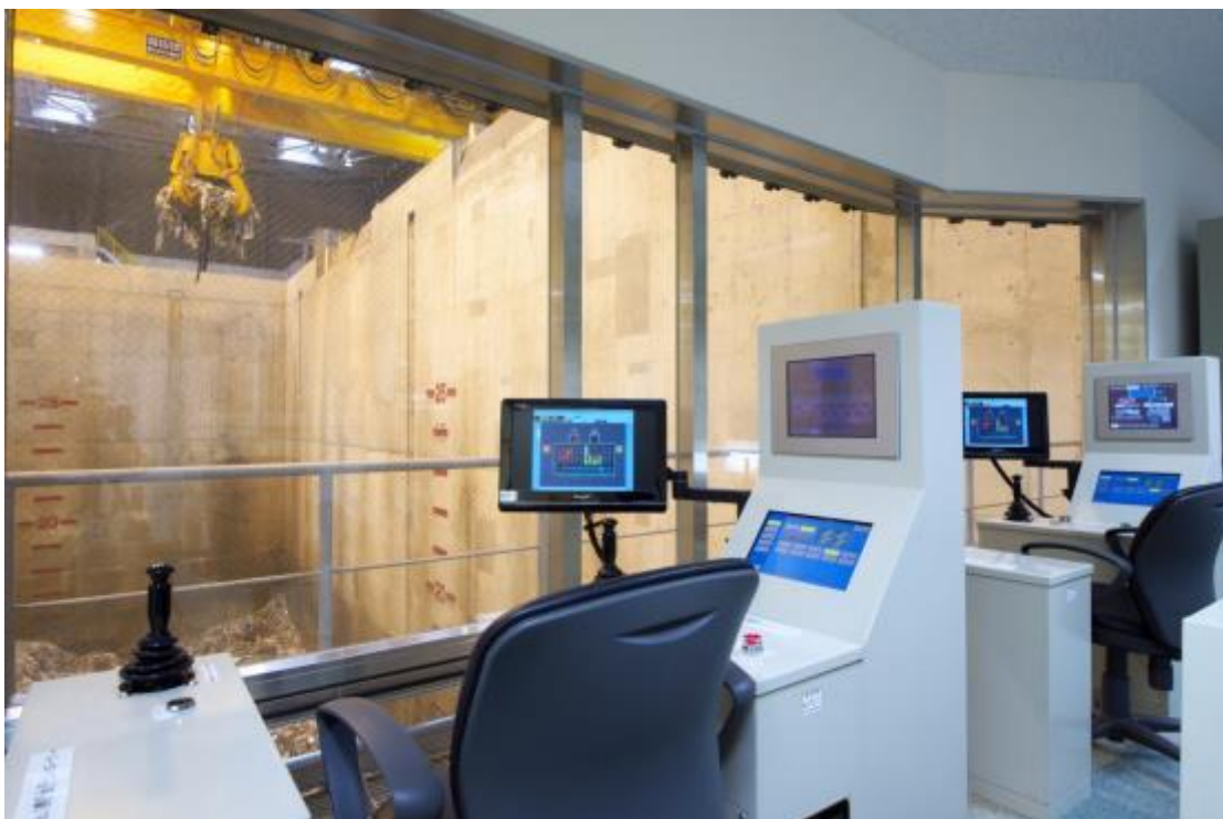
クリーンプラザふじみ ごみピット
