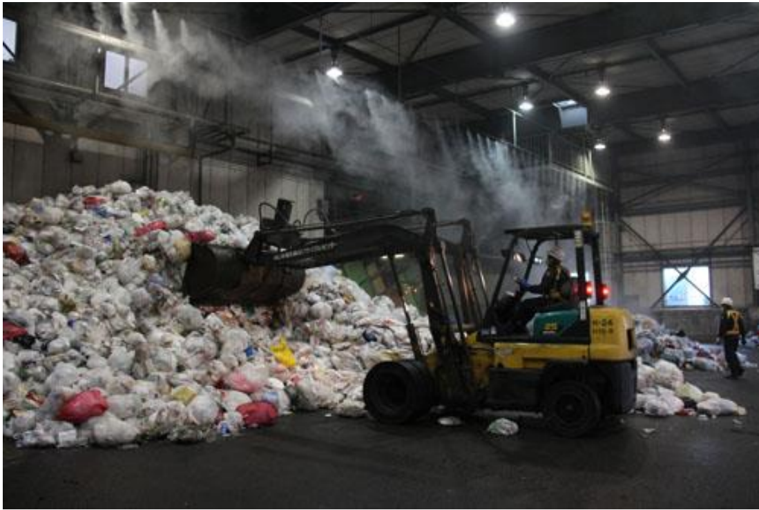
リサイクルセンター プラットホーム
