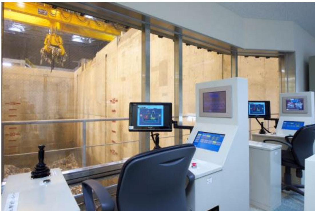
クリーンプラザふじみ ごみピット
