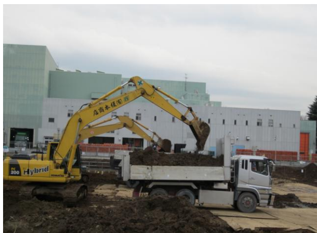
掘削土積込み
