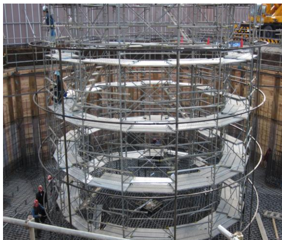
【煙突部の鉄筋組み立て】
