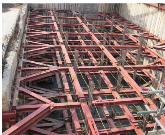
【ごみピット部の山留め】
