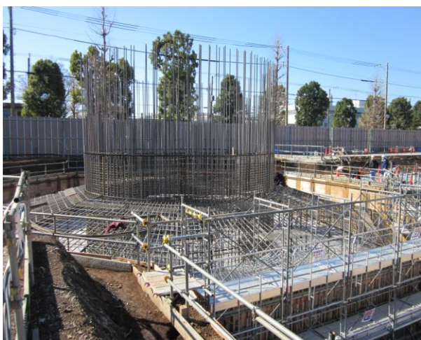
【煙突部の鉄筋組み立て】
