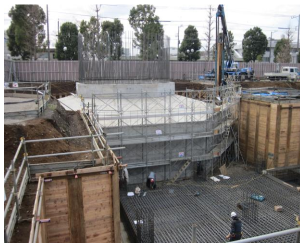
【煙突部の基礎工事状況】
