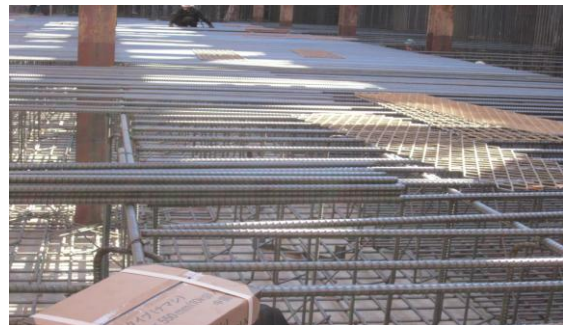
【ごみピット部の鉄筋組み立て】
