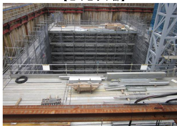
【ごみピット部】
