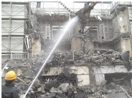
【解体工事施工例】
