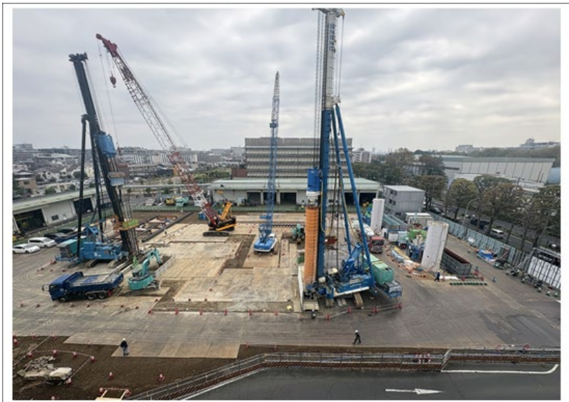
ごみピット周囲の山留設置工事中 (隣接する焼却施設から工事エリアを撮影)
