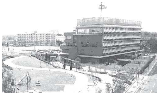
三鷹中央防災公園・元気創造プラザ
