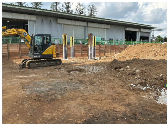
建物基礎部分の掘削状況
