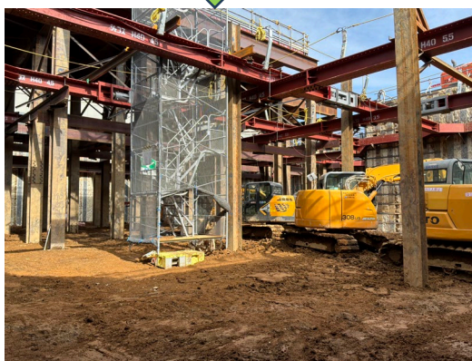
ごみピット内の掘削状況
