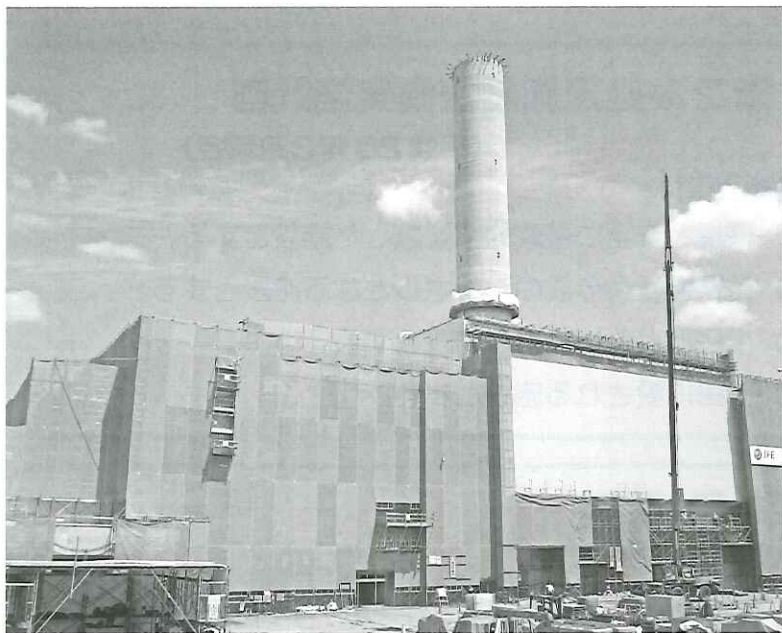
西側より施設を見る
