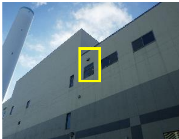
渡り廊下接続箇所（外観）
