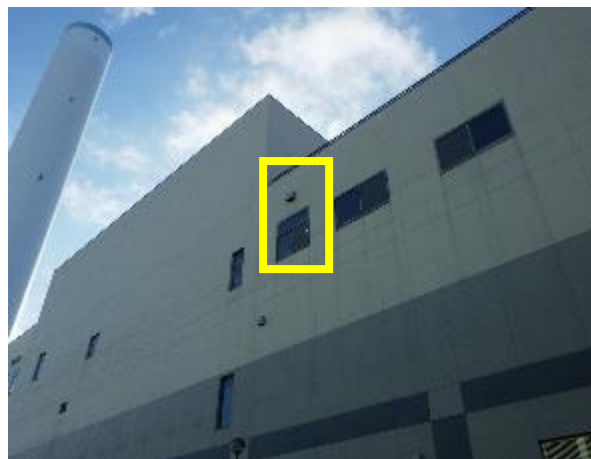
渡り廊下接続箇所（外観）
