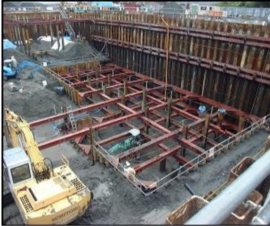
【地下部掘削工事】
