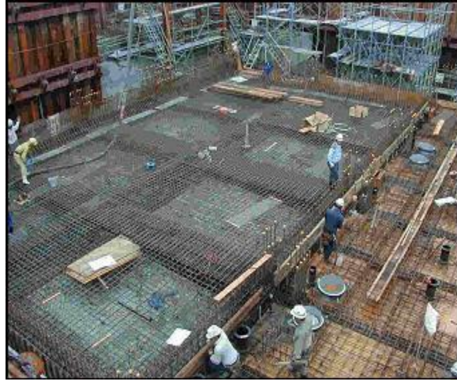
【ごみピット底盤配筋、コンクリート打設】
