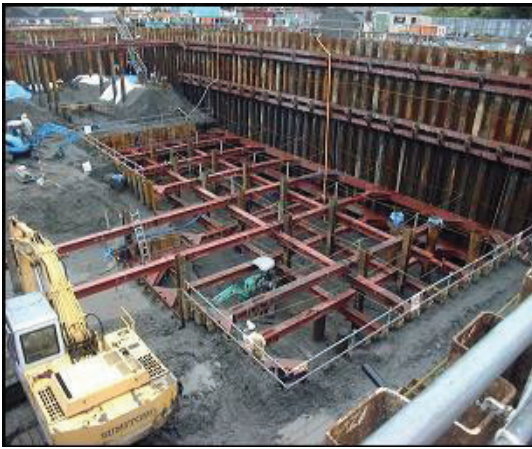
【地下部掘削工事】
