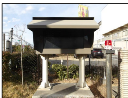
ふじみ衛生組合南ゲート
