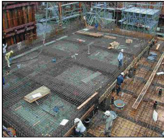
【ごみピット底盤配筋、コンクリート打設】
