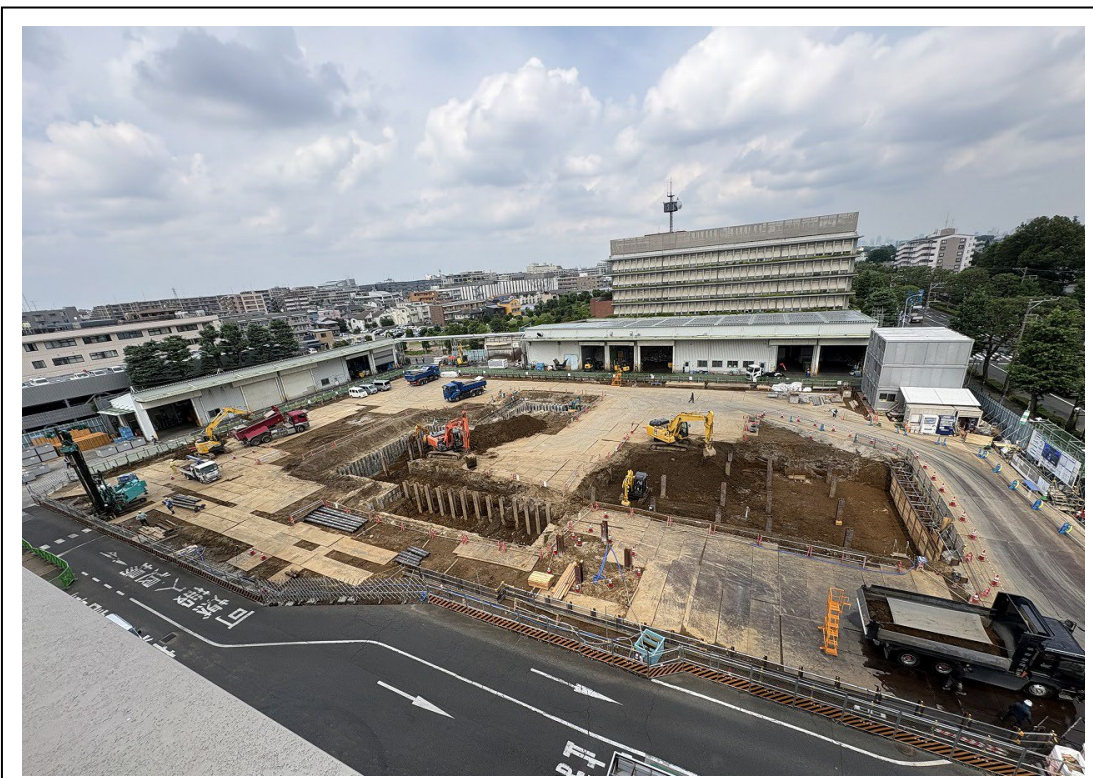
②（隣接する焼却施設から工事エリアを撮影） （ごみピット内掘削作業中）
