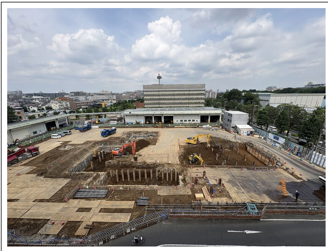
①（隣接する焼却施設から工事エリアを撮影）
